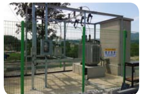
수변전 시설 방책 설치
